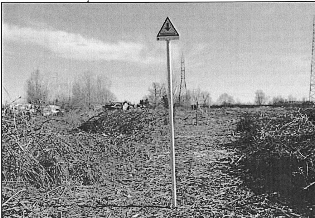
- palina infissa nel terreno indicante la presenza di un metanodotto
